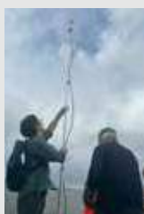
▲無線アンテナ設置
